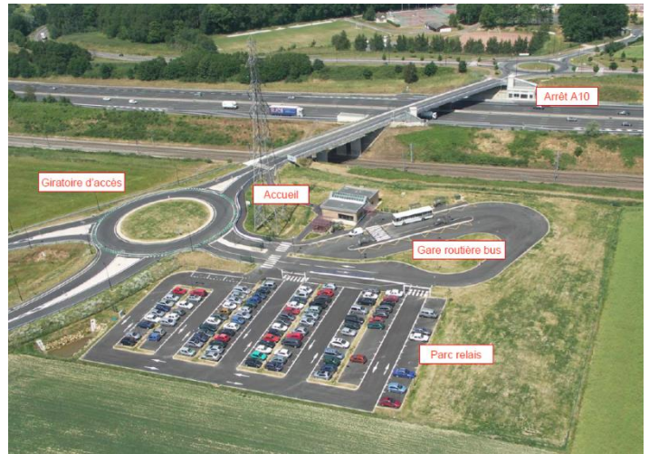
Figure 1 : Gare Autoroutière de Briis-sous-Forges (source : Essonne.fr)
