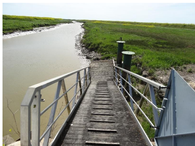
FIGURE 61 : EXEMPLE DE PONTONS SUR LE CANAL DU CURE (ANTOINE YOU)
