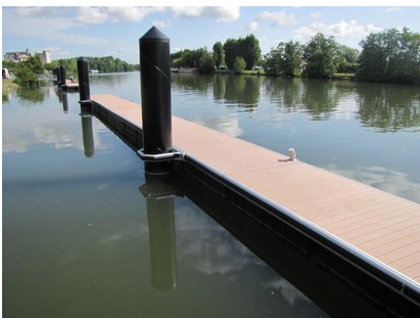
FIGURE 60 : PONTON FLOTTANT AVEC PYLONES DE GROS DIAMETRES (SOURCE HTTP://WWW.HANSEN-MARINE.COM )
