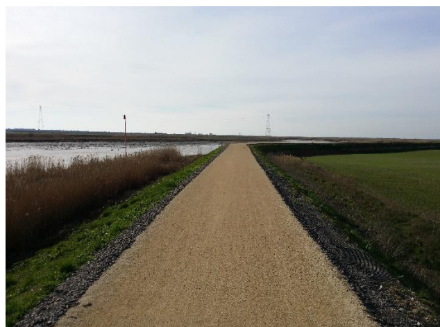
FIGURE 46 : AMENAGEMENT DE VOIE CYCLABLE DANS LE SUD DE LA VENDEE SUR DIGUE (ANTOINE YOU)
