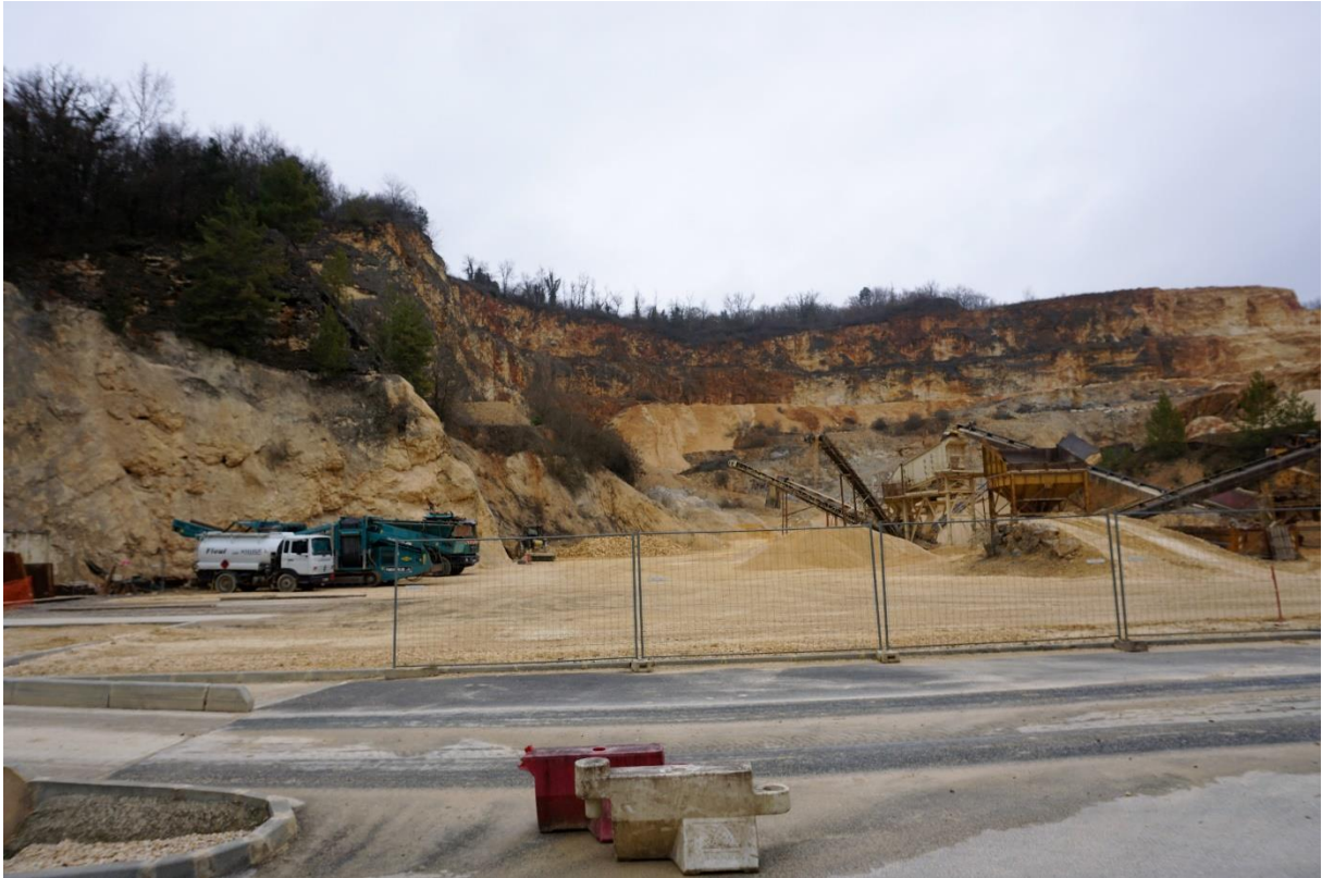
Photographie 2 : Zone de traitement de la carrière de Campagne (partie basse)
