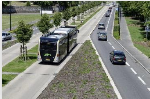
Figure 32 : Circuit du BusWay de Nantes (France) sur voirie entièrement indépendante du reste du trafic routier Source : http://media.daimler.com/
