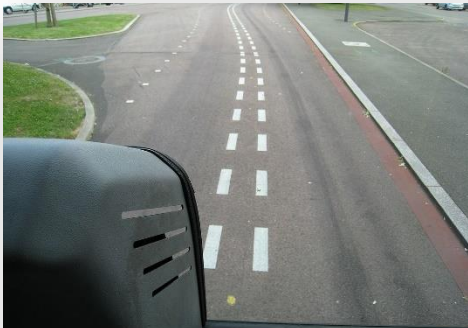
Figure 34 : Marquage au sol matérialisant la trajectoire optimale, lu et interprété par un guidage optique
