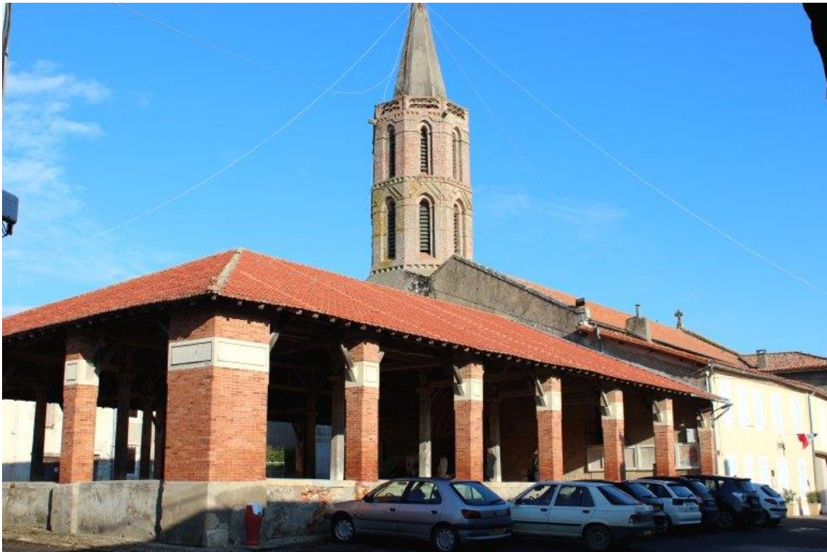
Figure 20 : Exemple de Halles
