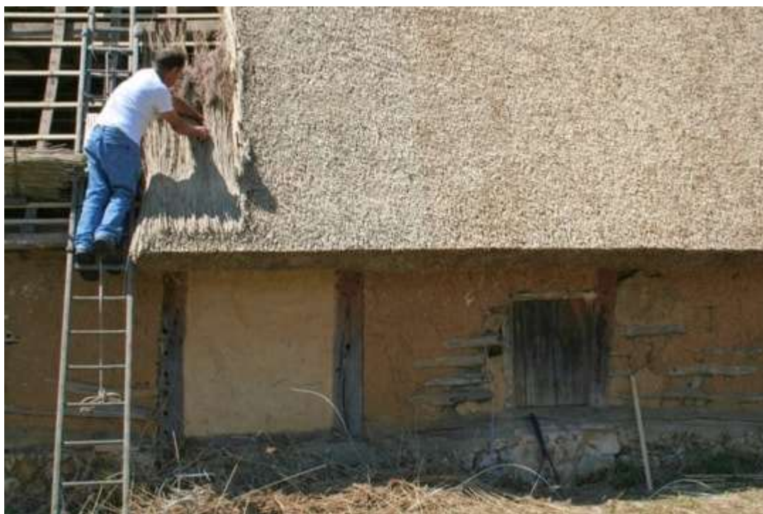
FIGURE 15 : POSE D'UNE COUVERTURE EN CHAUME (SOURCE : JEAN-CLAUDE TRIBOUT)
