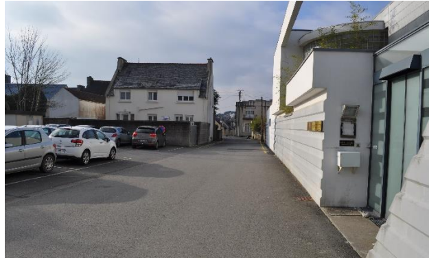
Figure 23 : Sortie du cabinet dentaire donnant accès sur la route
