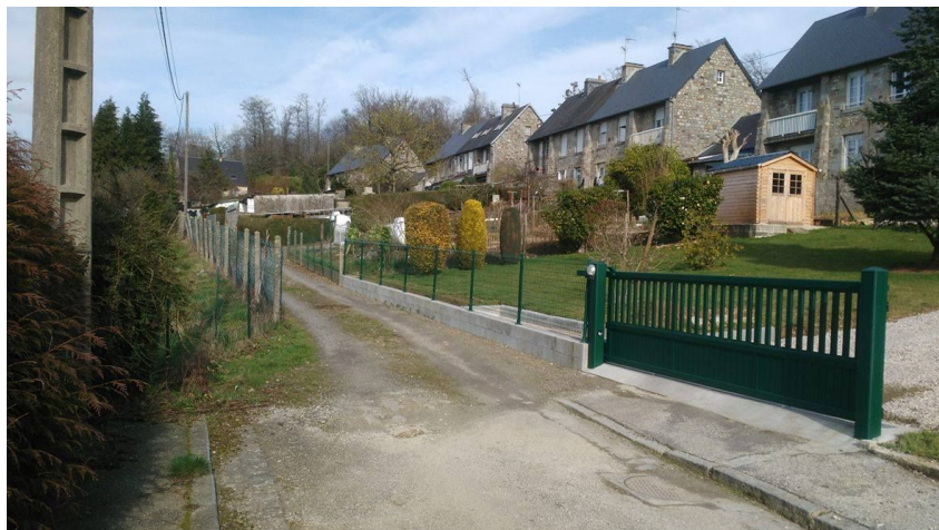
Photographie 3 : Les accès sont étroits, abîmés et colonisés par la végétation (réalisation : Vincent Nouailhat, date 28/02/2017)
