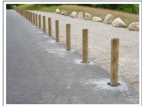
Figure 34 : Potelets en bois le long d'une route.
