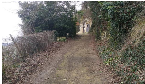
Figure 17 : Panorama de l'état de la voirie
