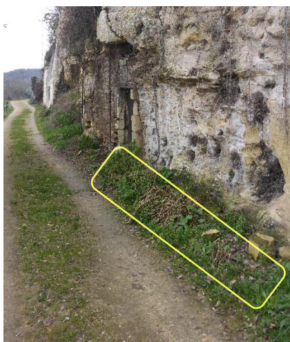
Figure 29: Exemple de portion d'herbe le long d'un bâtiment
