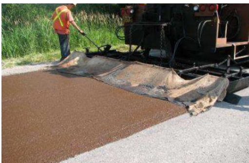
Figure 31: Photo d'un enrobé coulé à froid
