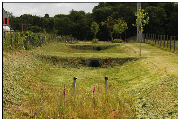
Figure 13 : Bassin de rétention enherbé (Source : pinterest.com)
