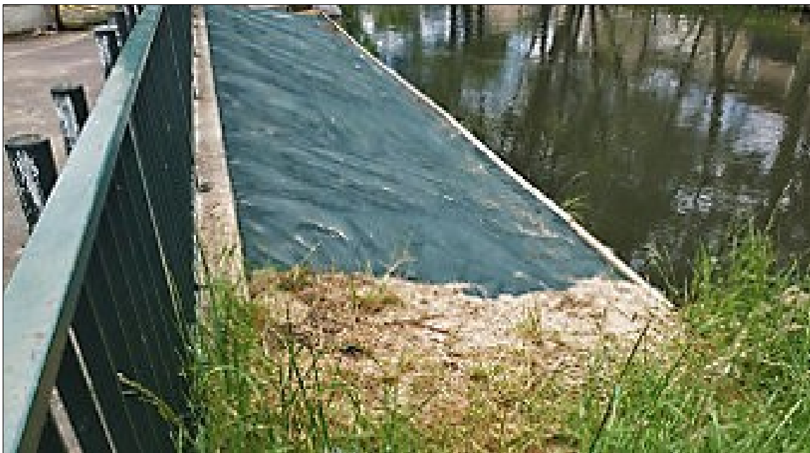
Figure 26 : Recouvrement d'une berge par une bâche (Source : http://www.dupontdenemours.fr )
