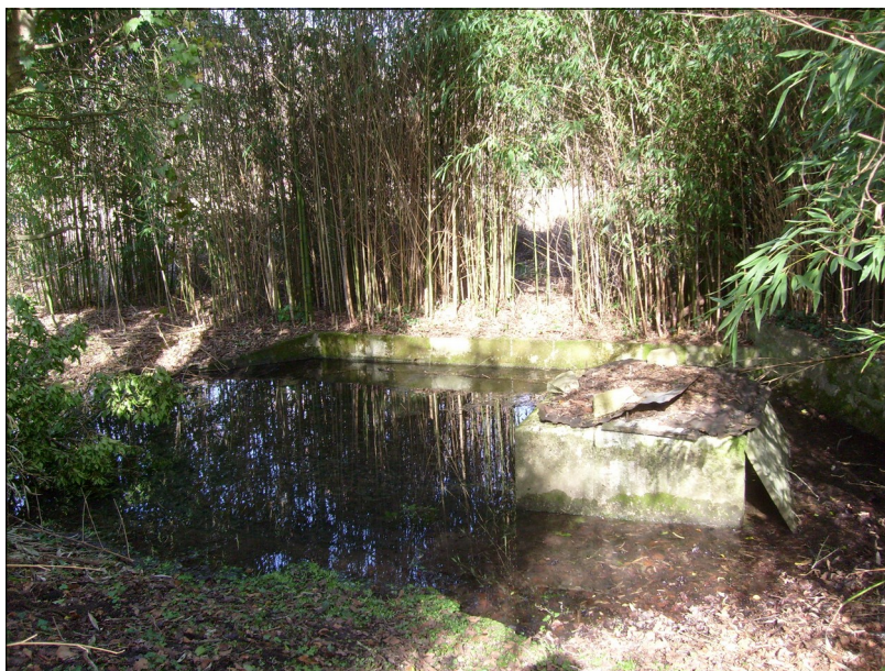
Figure 23 : Déviation de l'eau à cause d'embâcles (Source : Gaëlle JEAN)
