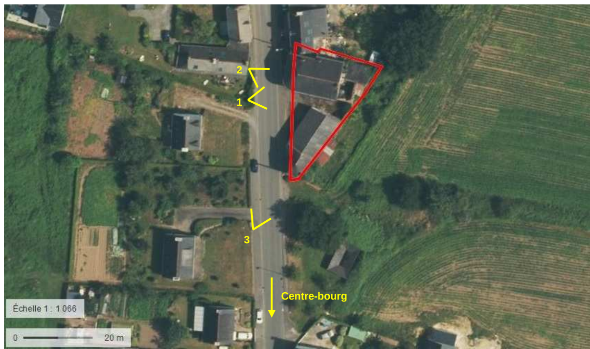
Photo 12 : Vue aérienne du site de l'ancien restaurant Photo : www.géoportail.gouv.fr / Montage : Sébastien Guillo
