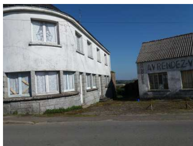
Photo 13 : Vue 1 du bâtiment n°2 Source : Sébastien Guillo
