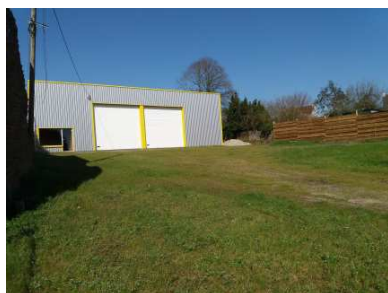
Photo 9 : Vue 1 du site de l'ancien garage Source : Sébastien Guillo
