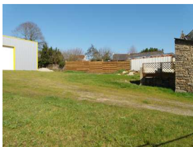
Photo 10 : Vue 2 du site de l'ancien garage Source : Sébastien Guillo
