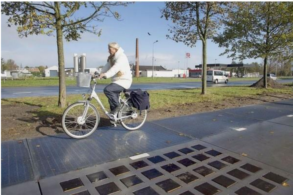
Figure 146: Une autoroute à vélo autosuffisante dotée de panneaux photovoltaïques aux Pays-Bas, source : www.la-croix.com
