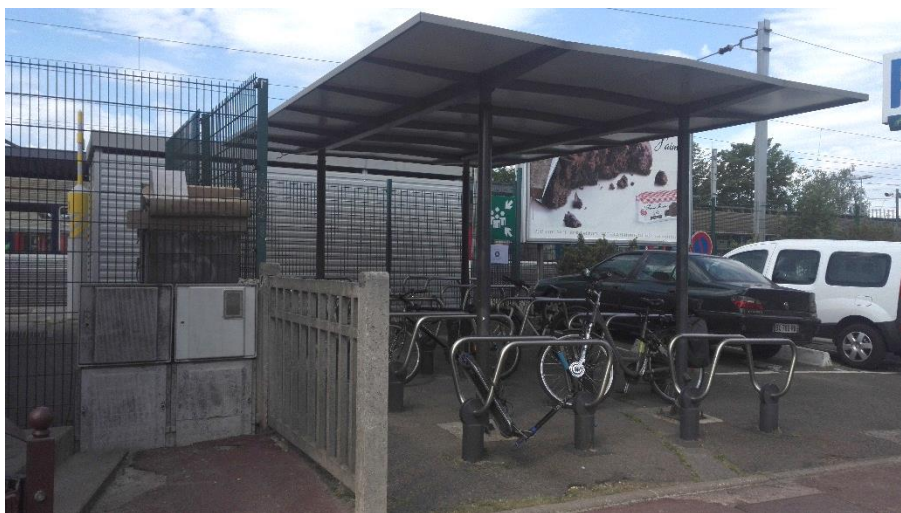
Figure 14: Abri vélo devant la gare
