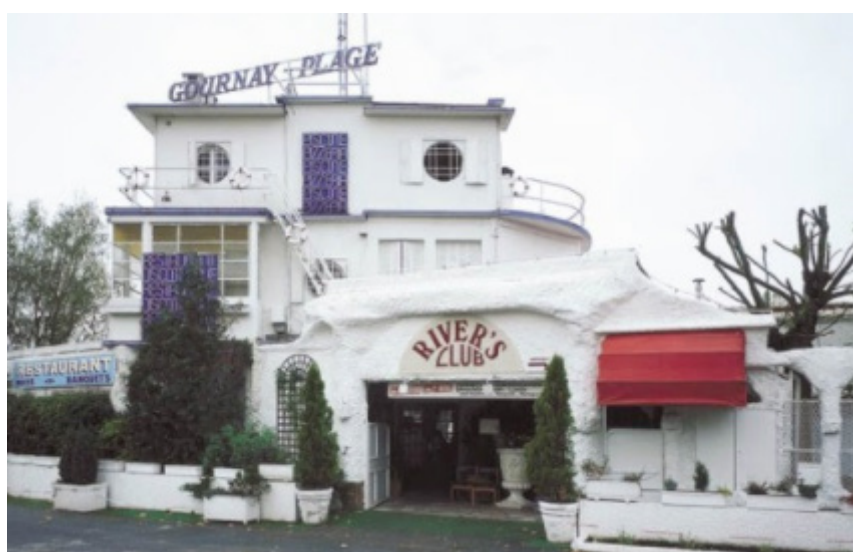
Figure 6 : Photo de La Plage à l'époque du restaurant - Source : Mairie de Gournay sur Marne
