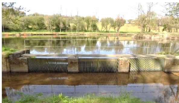
Figure 7 : Entrée d'eau en provenance de l'Argens par un by-pass et des vannes réglables. Photographie M. Boderiou.
