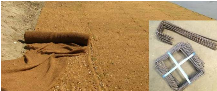
Figure 17 : Exemple du géotextile et des agrafes utilisées pour le génie végétal (Sources : Satar Environnement et la Compagnie Forestière)
