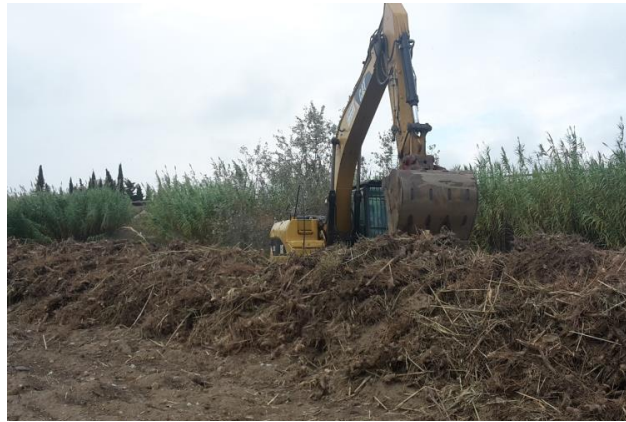
Figure 16 : Arrachage mécanique de Canne de Provence sur l'Agly (image personnelle)
