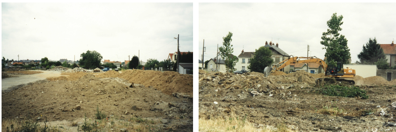
Illustration 4: Photographies des travaux en juin 1996
