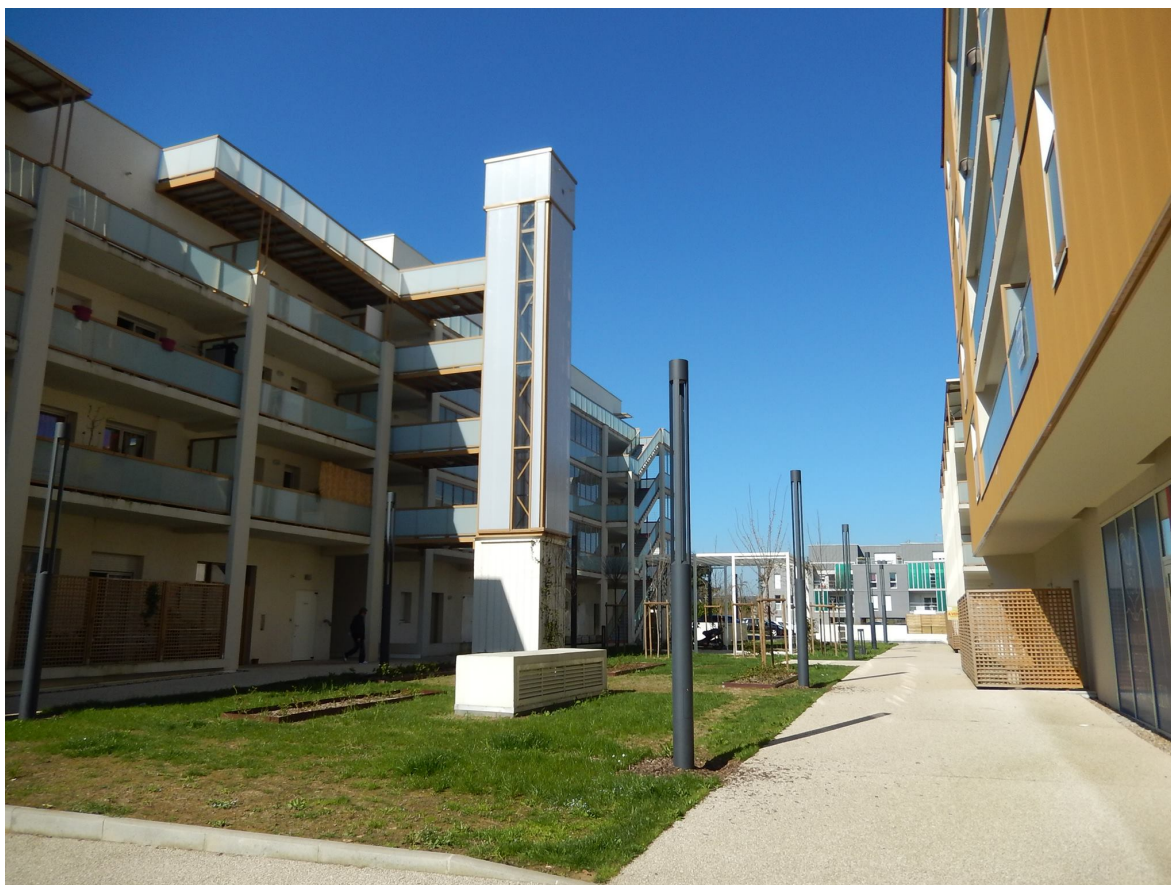
Figure 4. Exemple 2 de logements collectifs à Monconseil – 9 mars 2017
