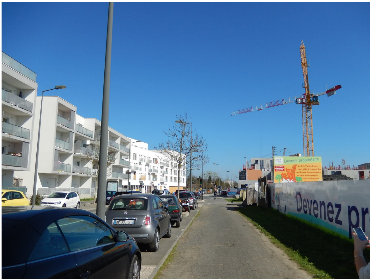
Figure 7. Monconseil actuellement en travaux – 9 mars 2017
