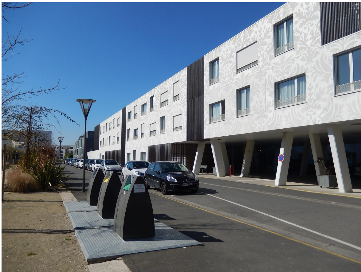
Figure 5. Exemple 3 de logements collectifs à Monconseil – 9 mars 2017
