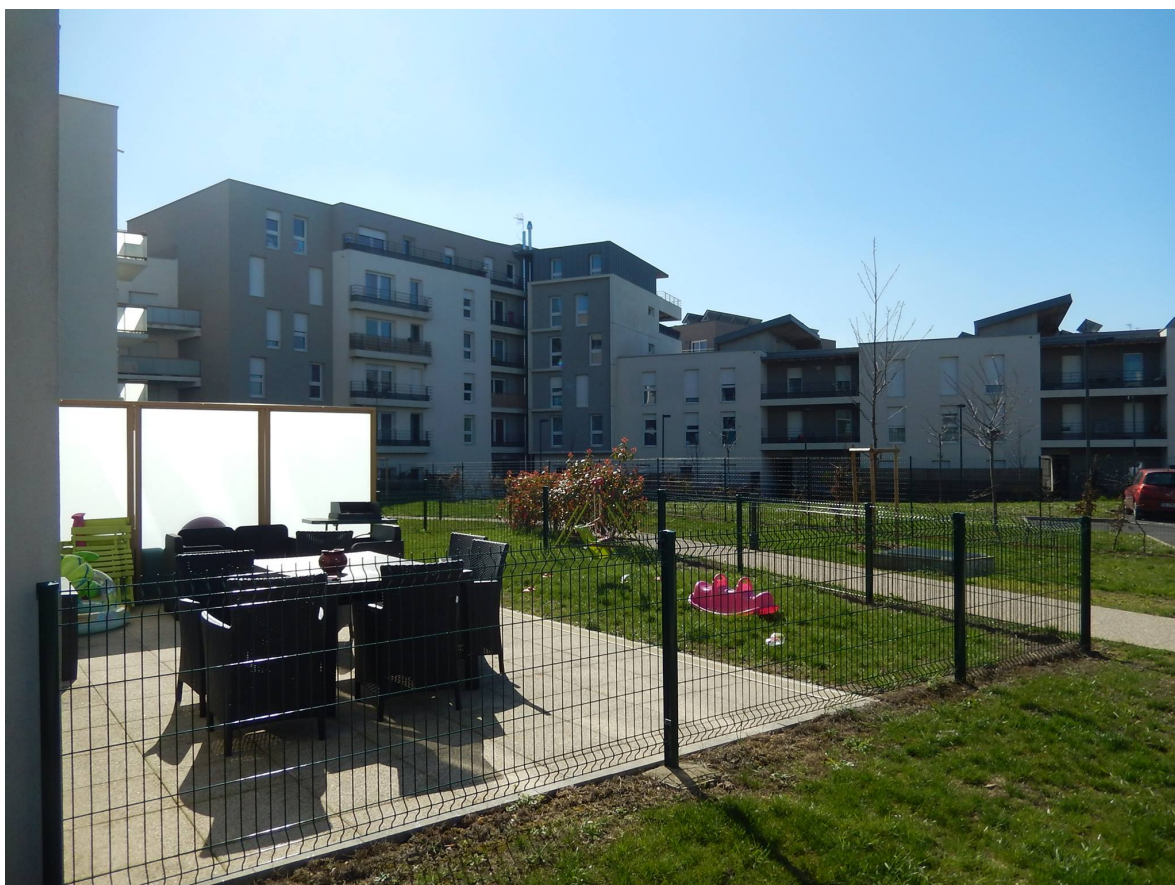
Figure 6. Exemple 4 de logements collectifs à Monconseil – 9 mars 2017
