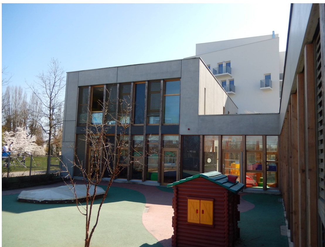
Figure 2. Crèche de l'écoquartier – 9 mars 2017
