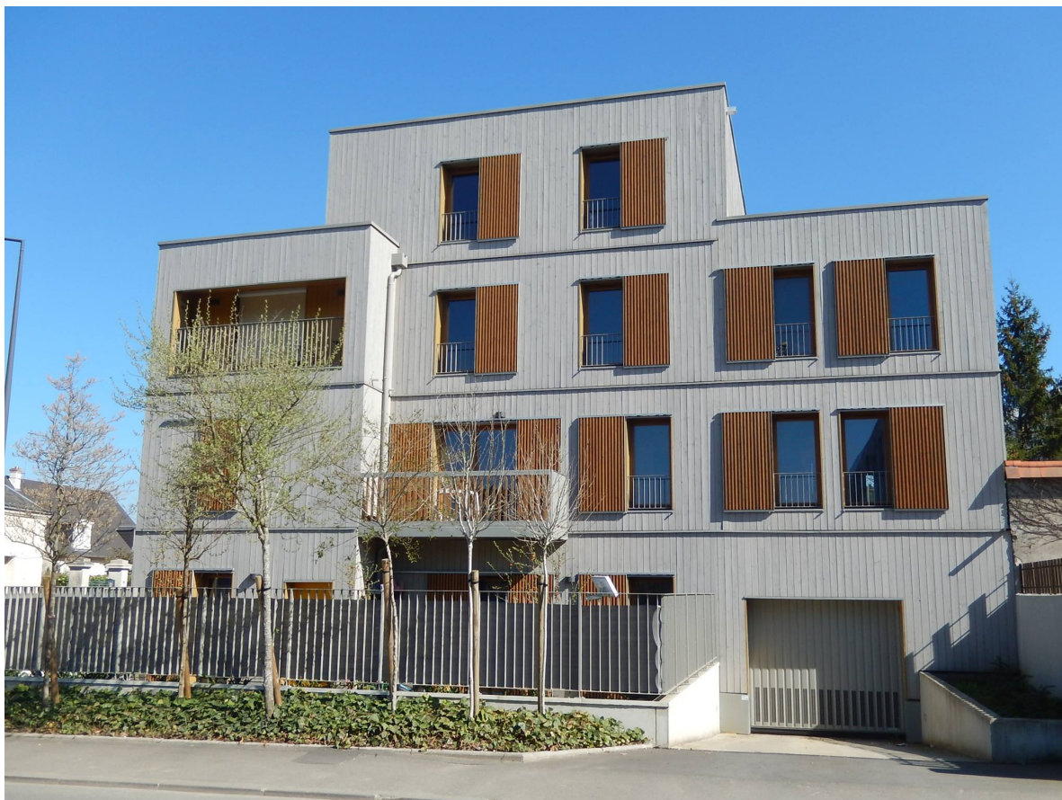
Figure 3. Exemple 1 de logements collectifs à Monconseil – 9 mars 2017
