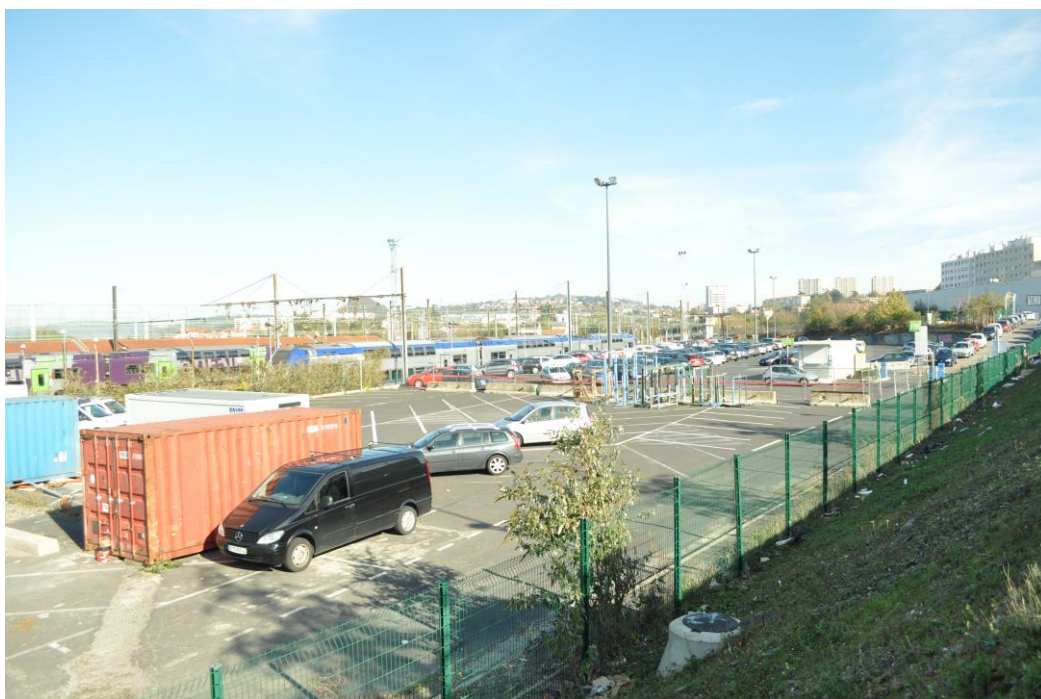
Photo 4 : Secteur du CNCesu, à Châteaueux, avant travaux, source www.epase.fr
