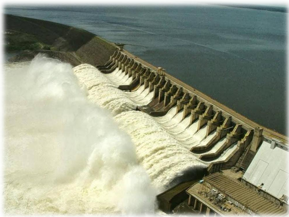
Figure 5 : Barrage de Tucurui (source : http://www.beevar.com )
