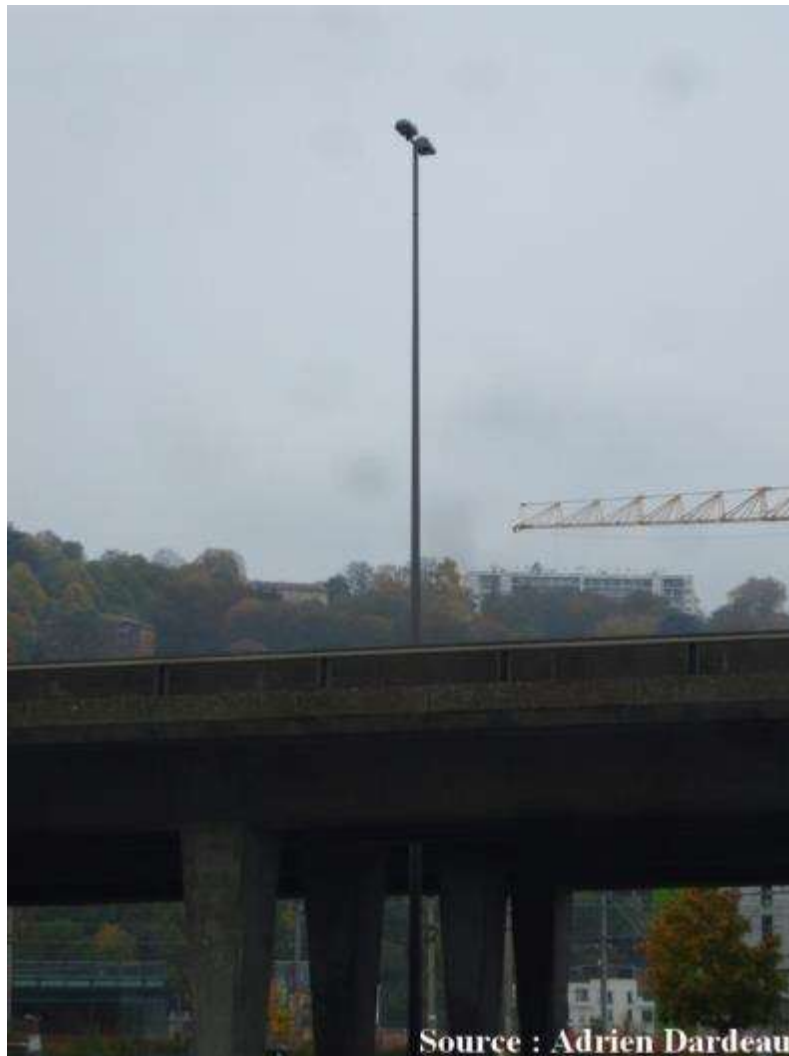
Figure 12 - Les luminaires autoroutiers au niveau du musée de la Confluence ne sont pas installés sur le pont mais à même le sol.
