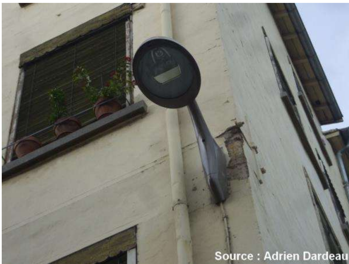
Figure 2 - Un lampadaire à LED orienté vers le sol, un des modèles prônés par la politique de développement durable.
