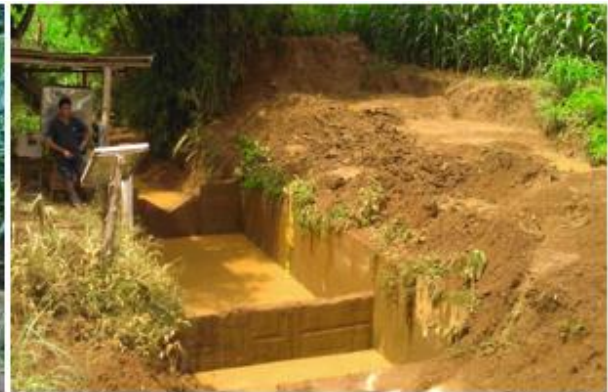
Figure 21 : Cuves après intervention.
