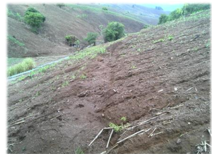
Figure 3 : Terrasse dégradée par l'érosion.
