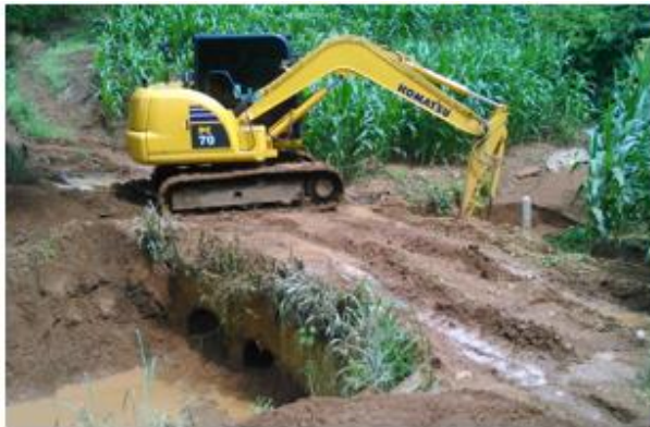
Figure 20 : Intervention après épisode pluvieux.
