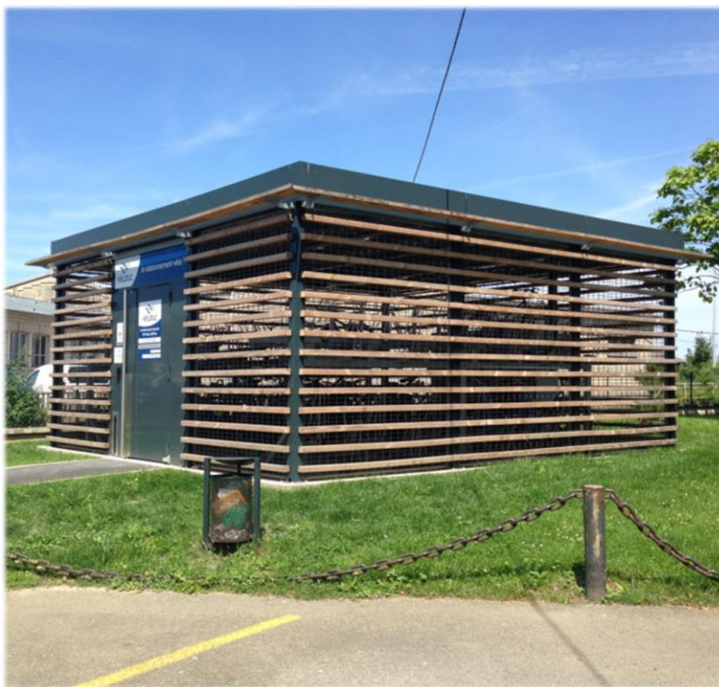
Abri sécurisé à la gare de Compiègne (Source : altinnova.com)
