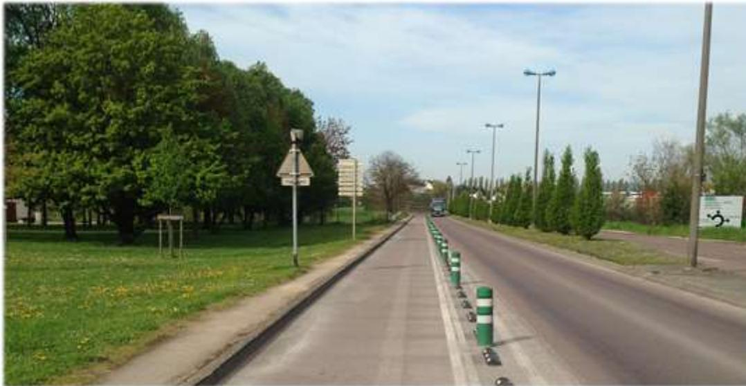
Figure 163 : Exemple de potelets qui séparent la bande cyclable de la route (Photographie : Ali BENFADEL)
