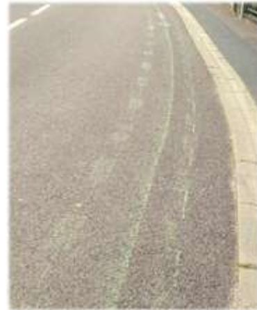
Figure 95 : Panneau caché par une végétation envahissant dans la rue du Cras à Givry (à gauche) et effacement de la bande cyclable de la rue François Protheau à Chalon-sur-saône (à gauche)
