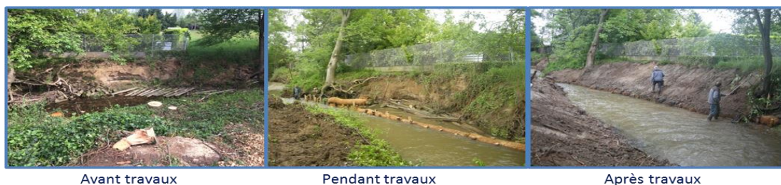
Figure 5: Cas concret de restauration de berges sur l'Anzieux
