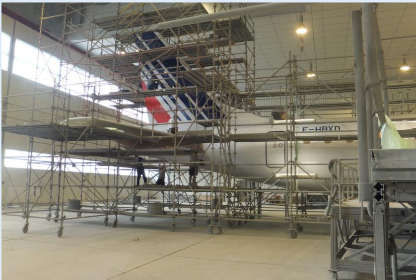
Figure 37 : Hangar de maintenance de l'aéroport Marcel Dassault de Châteauroux-Deols
