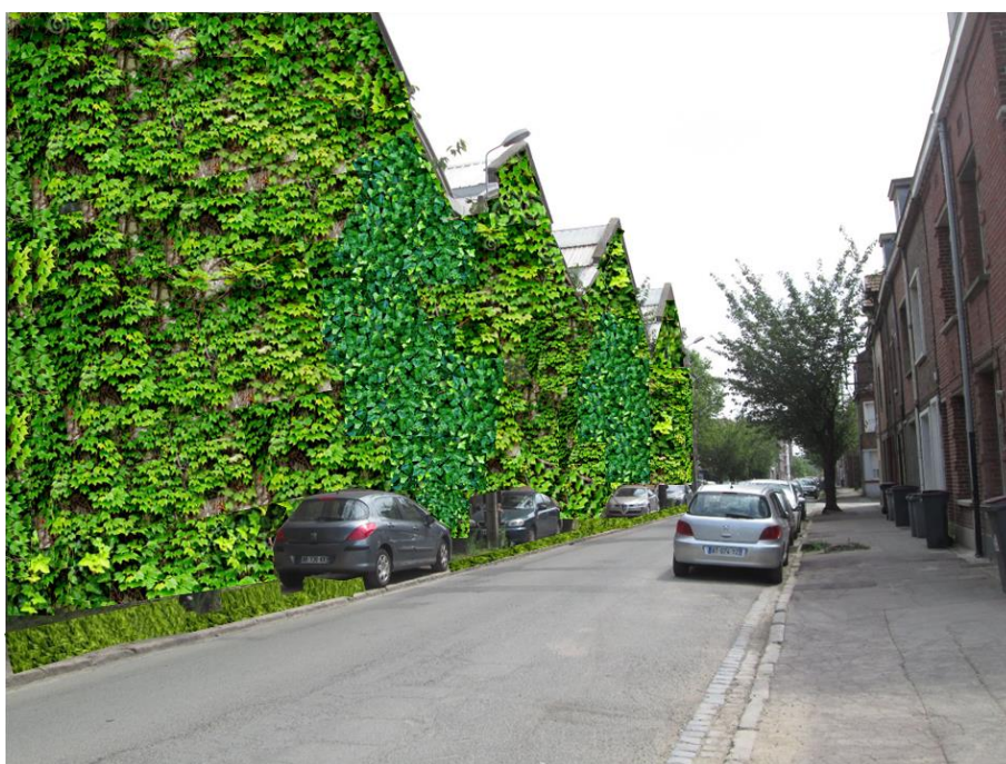
Figure 104 : Façade recouverte de lierre rue W. Churchill
