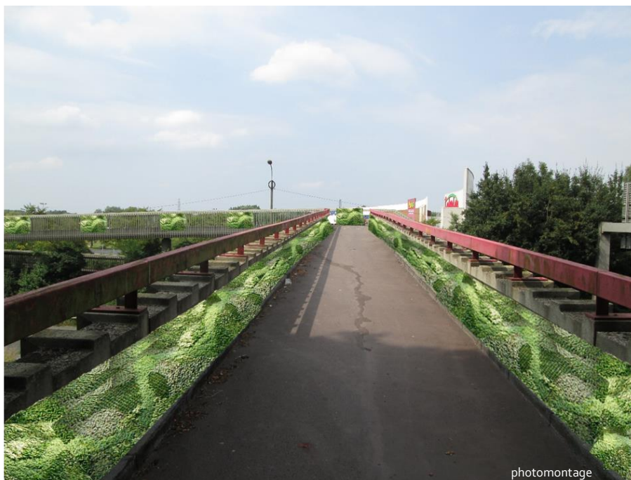
Figure 67 : Système de mur végétal sur la passerelle piétonne
