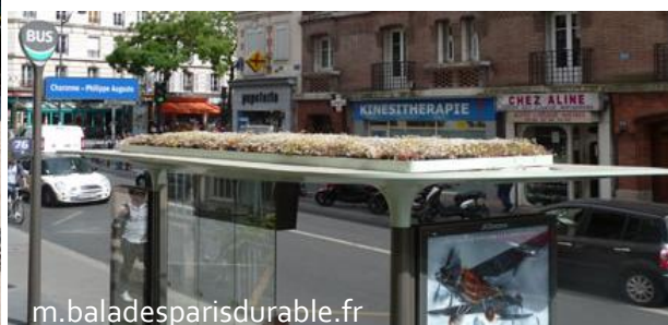
Figure 81 : toiture végétalisée d'un abri bus parisien
