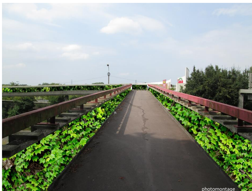
Figure 67 : Passerelle piétonne végétalisée par du lierre
