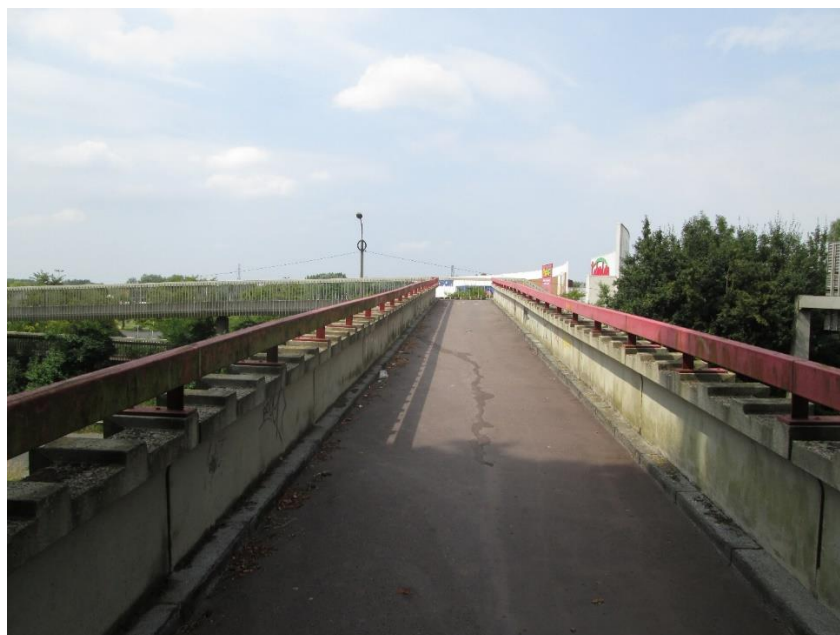
Figure 66: Vue actuelle de la passerelle piétonne de la RNO (22/07/2016)
