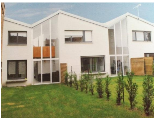
Figure 16 Maisons en bande - Source : CERTU
