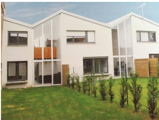
Figure 4 Maisons en bande - Source : CERTU
