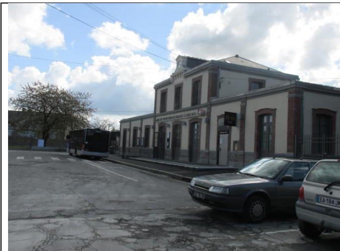
Figure 15 : Façade de la gare, parking voitures et bus (sur la photo : navette allant au Mont-Saint-Michel)
