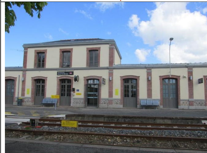
Figure 17 : L'autre côté de la gare, les deux voies de chemin de fer (celle plus au fond est celle rénovée)
