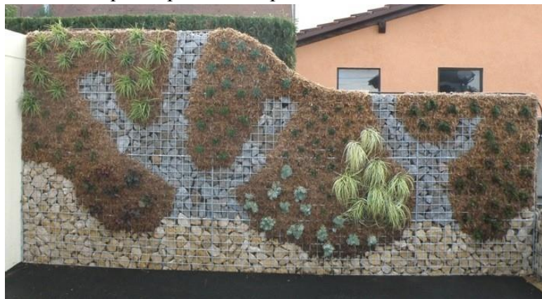
Image 17: Mur antibruit en pierre et végétation, source: devis clôture
