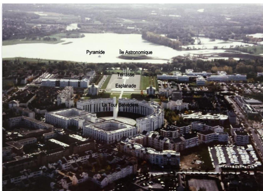
Figure 26 : L'Axe Majeur avec l'Île Astronomique en construction, Archives départementales du Val-d'Oise, côte 443 W21
