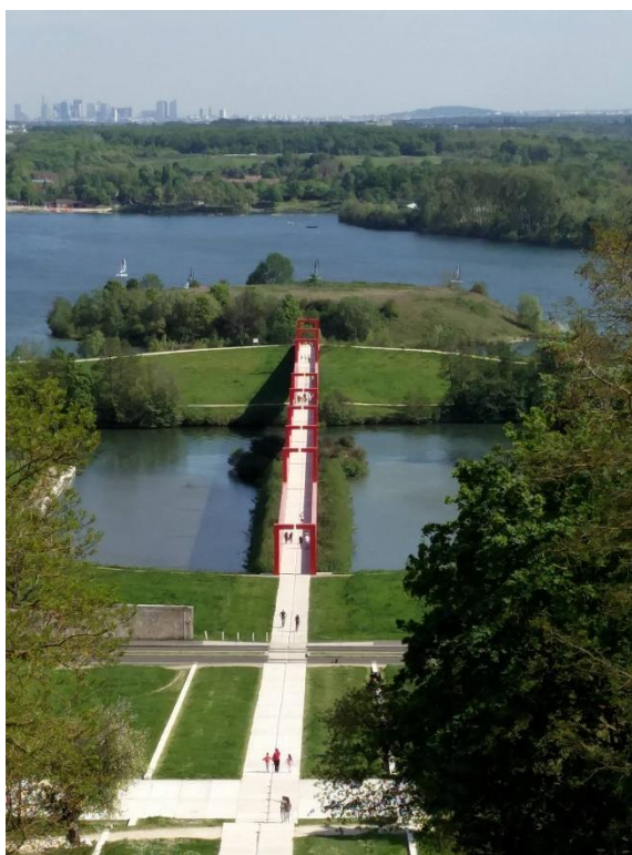
Figure 45 : La Passerelle qui surplombe la Scène, le Bassin et l'Oise. Réalisation de Thibault Watremez
