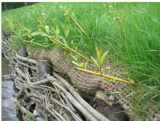
Figure 38 : Réhabilitation de berge par tressage. Source : le blog de Pico92
