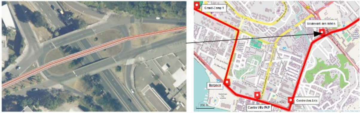
Illustration 29: Insertion de du rond-point en hauteur à l'intersection entre la N1 et le Boulevard des Héros (A.Noel)
