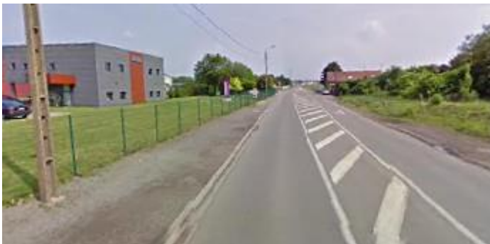
La RD 645 longe la ZI par le Nord. Un arrêt y serait créé ainsi qu'une voie piétonne pour relier la zone à la voirie. Enfin, un passage piéton serait implanté.
