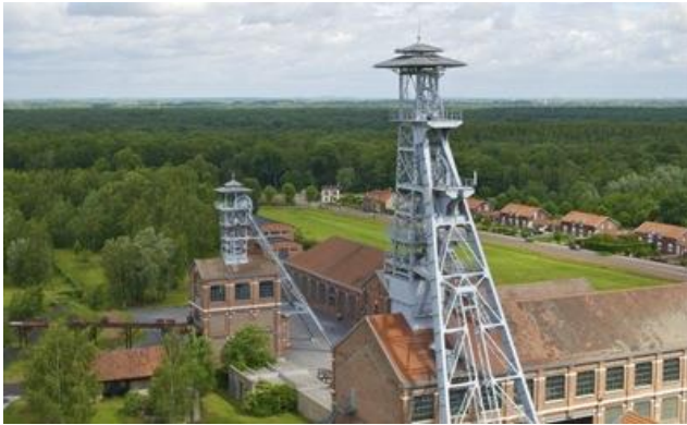
Chevalement à Wallers (59). On aperçoit derrière un habitat caractéristique des cités minières
