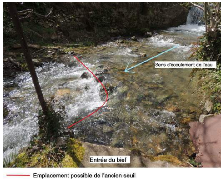
FIGURE 7.6 – Emplacement du seuil - Source personnelle
