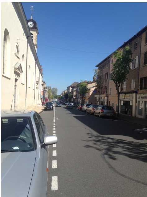
Illustration 22: Aménagement actuel le long de la façade de l'Hôtel-Dieu rue de la République
