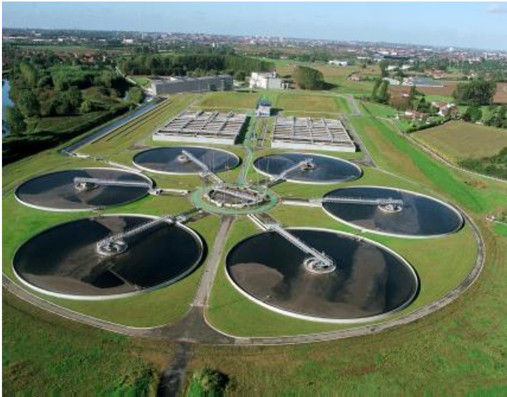
Figure 27 : The Shatin Sewage Treatment Works (Station d'épuration de la ville de Sha Tin, Hong Kong)
