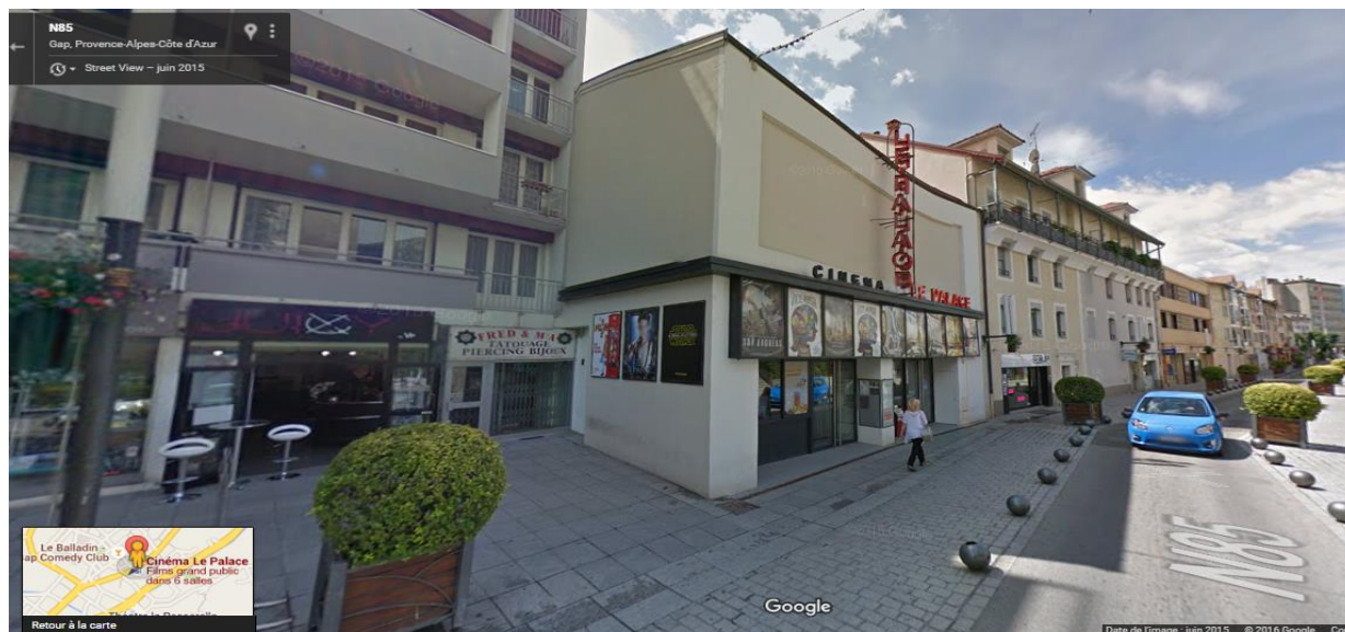
Figure 17 : Emplacement du cinéma le Palace au milieu de commerces et habitations
