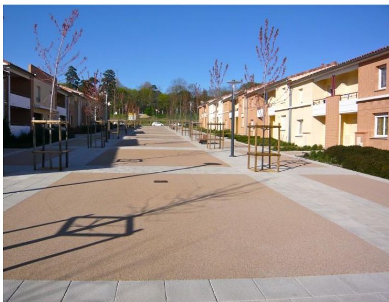
Figure 82 : Exemple d'allée piétonne avec un revêtement Permeaway Urban (Source : permeaway.fr)
