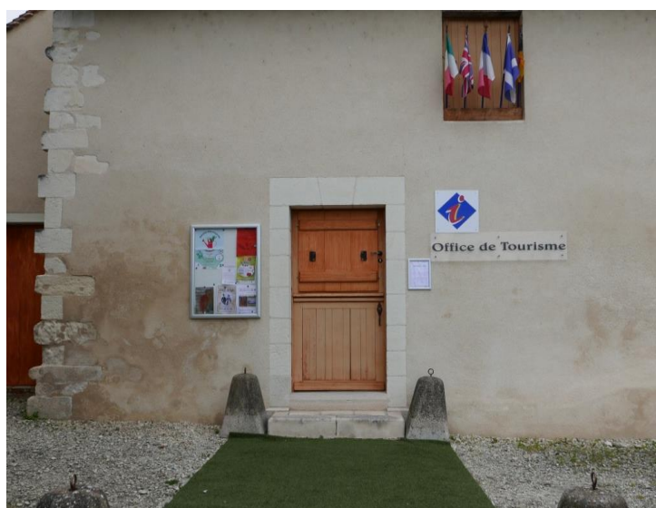
Figure 78 : Entrée de l'office de tourisme (Source : Fabien Clouet)
