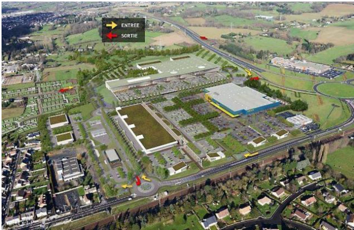
Figure 18 : Photographie du projet de zone commerciale à Bener
