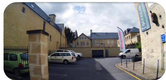
Parking rue des Cuisiniers
