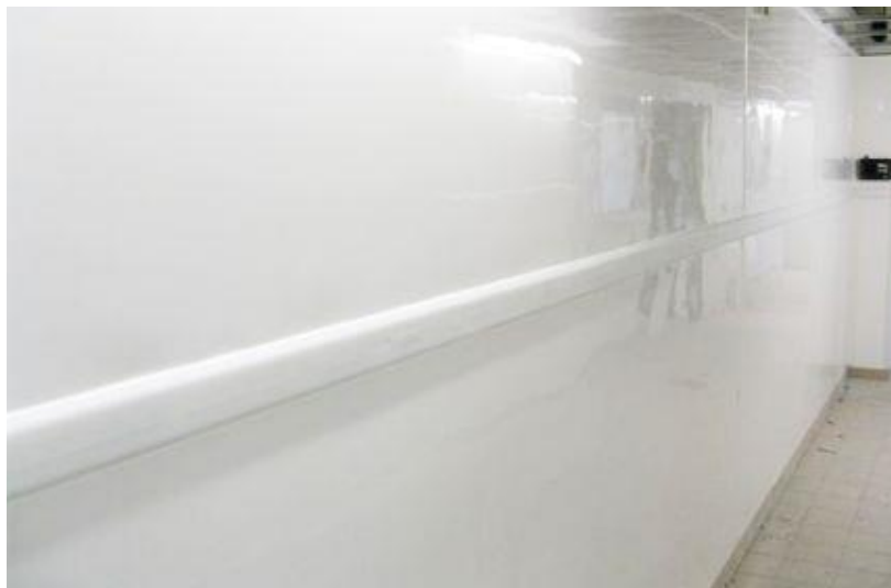
Figure 42 : Exemple de revêtement mural dans l'agroalimentaire ( arclynn.com )
