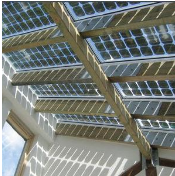
Figure 38 : Panneaux photovoltaïques installés en verrière (archiexpo.fr)
