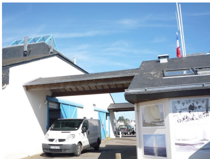
Figure 19 : Photographie des antennes relais et du couloir extérieur reliant la criée et la capitainerie
