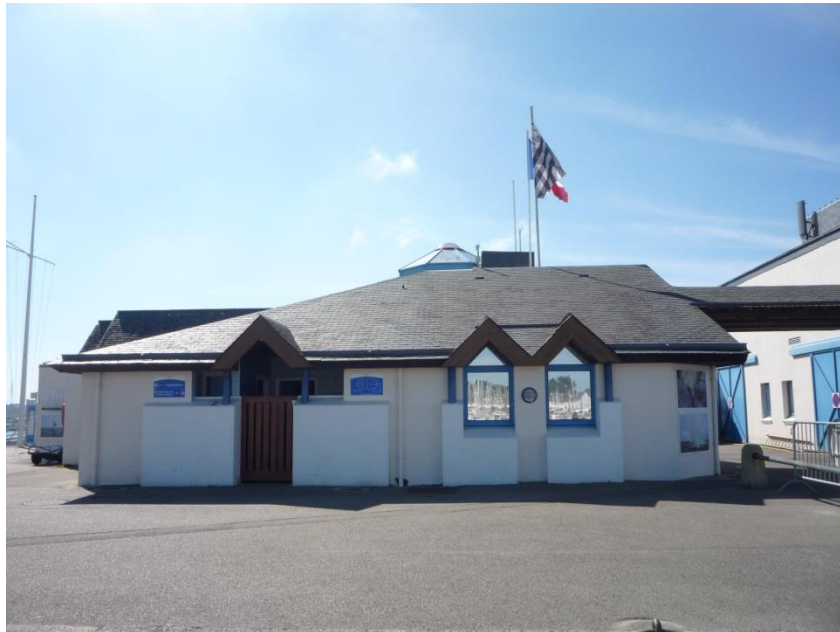
Figure 14 : Photo de la capitainerie et des sanitaires
