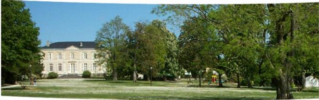
Figure 15 - Parc de Nieul sur mer (source : nieul-sur-mer.fr)
