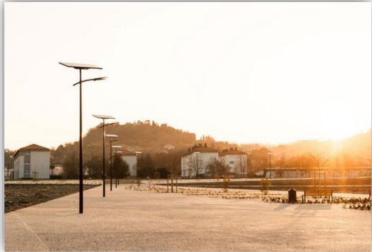
Figure 38 - Installation lampadaires autonomes SMARTLIGHT à Donnefort, Agen (47) (source : http://www.fonroche.fr )
