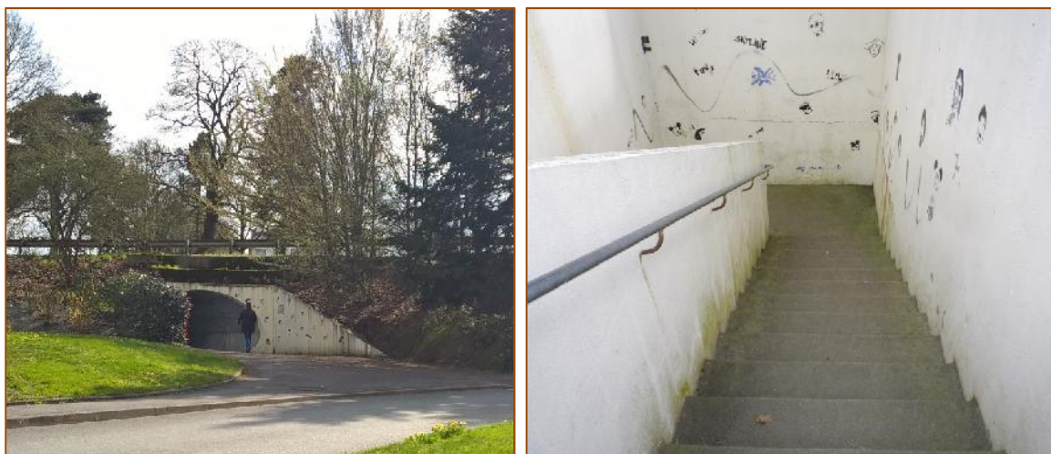
Figure 22 : Entrée Nord et Sud du tunnel
