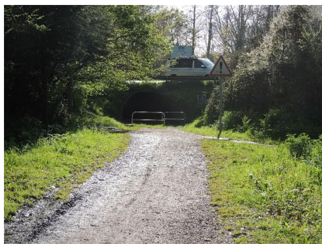
Figure 7 : Tunnel sous la D492 – E. Aunay – 14/04/2016
