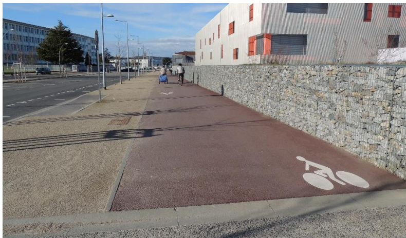
Figure 9 : Séparation de la piste cyclable et de la partie piéton au niveau de l'avenue Pierre de Coubertin – E. Aunay – 11/04/2016
