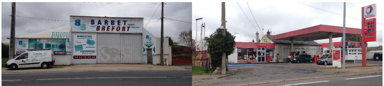
Photographie 5 : Activités commerciales dans le déversoir Source : F. DELONIN et R.TORRENT
