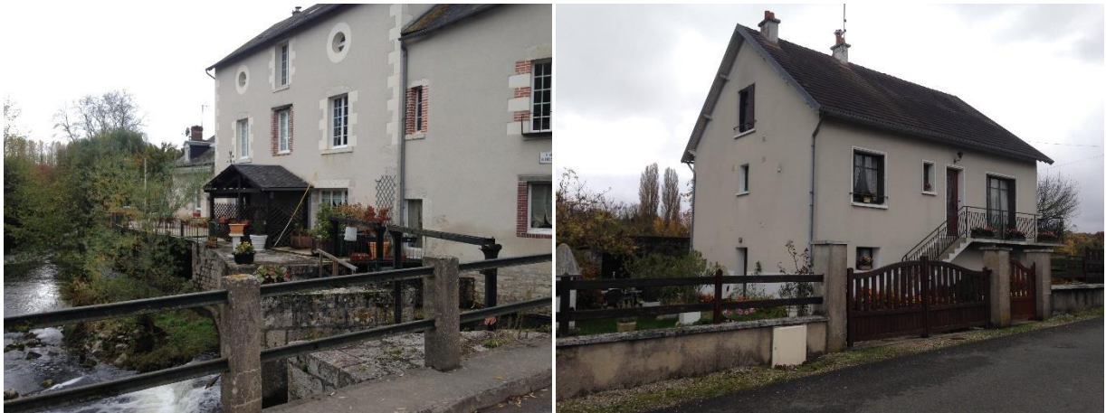
Photographie 7 : Types d'habitat présents dans la zone du déversoir Source : F. DELONIN et R. TORRENT
