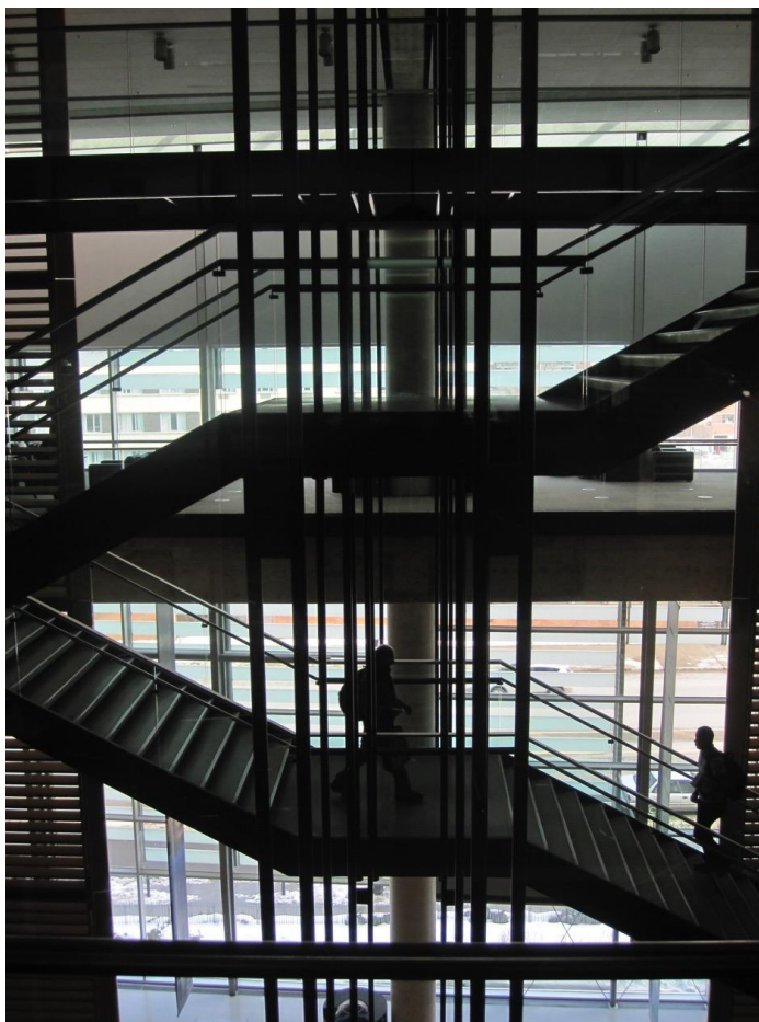
Photo 14 : Vue des escaliers depuis l'ascenseur, on peut voir les petites rambarde dédiées aux enfants
