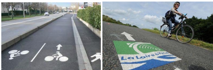
Figure 26 : Pictogramme classique (à gauche) et pictogramme spécifique à la Loire à Vélo (à droite) (Sources : FFCT, Larep)
